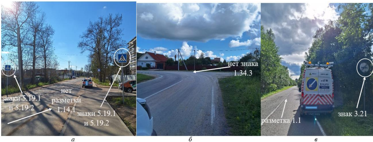
а – отсутствие или недостаточная видимость горизонтальной разметки; б – отсутствие дорожных знаков в необходимых местах; в – некорректное применение и плохая различимость установленных знаков
